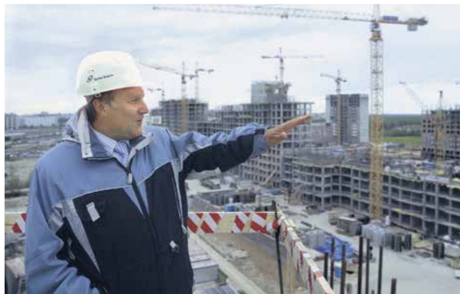
Вячеслав Заренков, на строительной площадке, девелоперская Группа «Эталон» | ФОТО ИЗ ЛИЧНОГО АРХИВА В. А. ЗАРЕНКОВА
